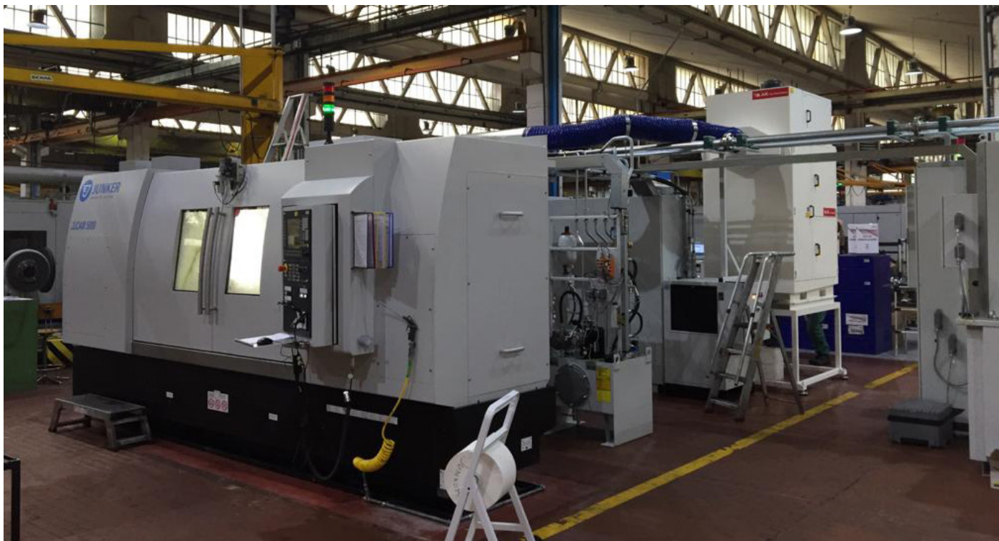
INSTALLAZIONE COALFILTER SU RETTIFICA JUNKER
